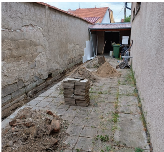
Dvorek před rekonstrukcí
